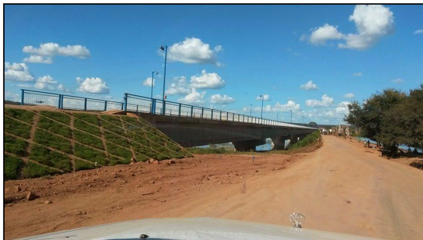
Photo 30: Nouveau pont de Lualaba
